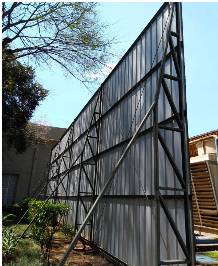
Ilustración 54. Foto de la estructura metálica a intervenir.
