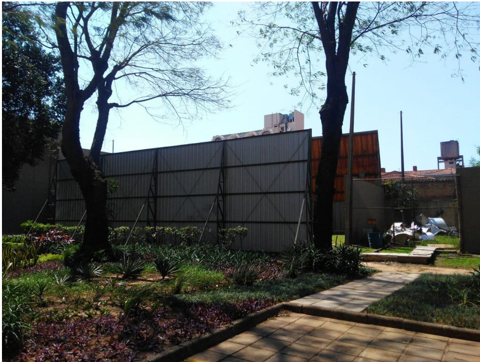
Ilustración 53. Foto de la estructura metálica a intervenir.
