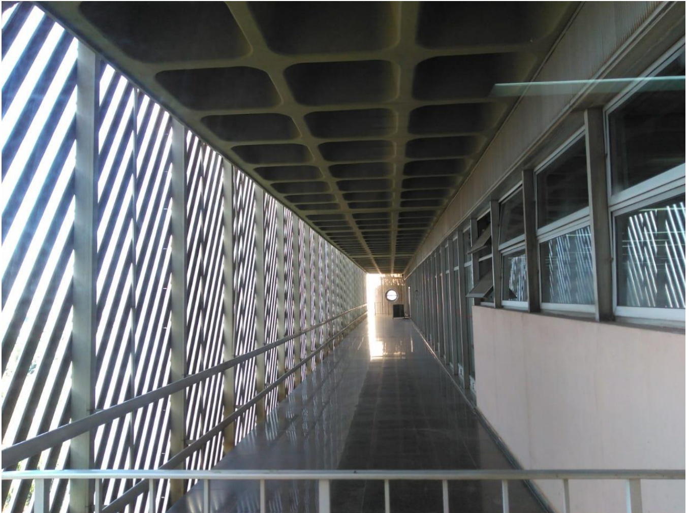
Ilustración 20. Foto de la situación actual de las galerías. Piso 6 Banco.
